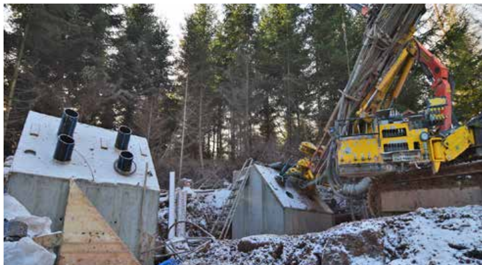
Errichtung erster Abspannfundamente für die Hängebücke auf dem Sommerberg. Foto: Wolfgang Kienzler
