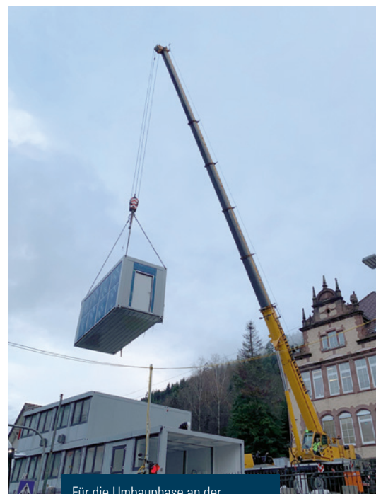
Für die Umbauphase an der Fünf-Täler-Schule werden das Rektorat und drei Klassenzimmer in hochwertigen Containern untergebracht.
