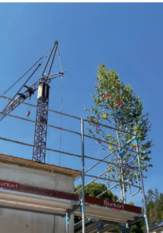
Richtfest an der Fünf-Täler-Schule zur Fertigstellung des Gebäudeteils C
