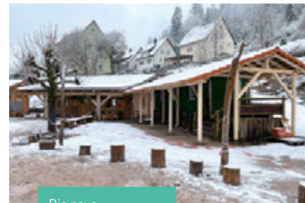
Die neue Überdachung des Bauwagens im Naturkindergarten
