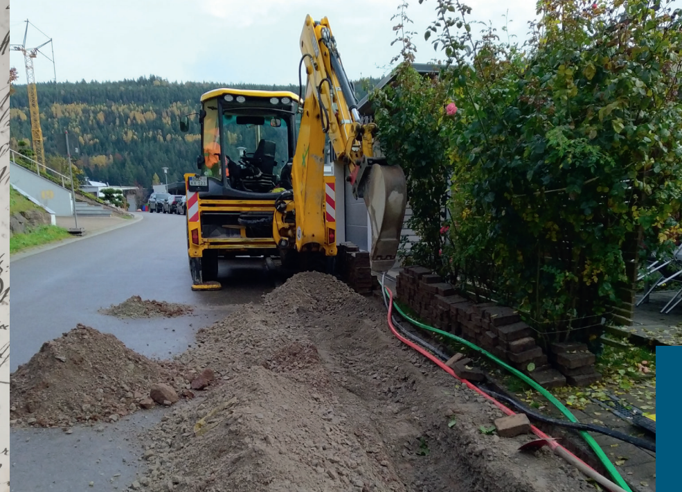
Verlegung der Kabel und anschließende Wiederherstellung der Gehwege im Bereich Wicharts-Straße.
