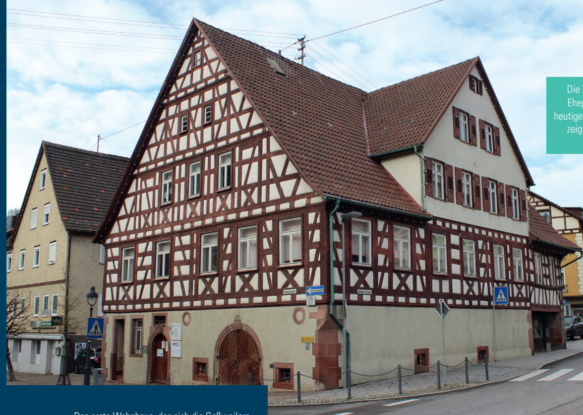
Das erste Wohnhaus, das sich die Goßweilers in Calmbach 1752/53 bauten, beherbergt heute das Rathaus.
