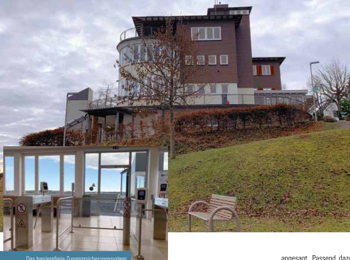
Das barrierefreie Zugangssicherungssystem mit Drehkreuzen und Schranken sorgt für einen geregelten Zugang, was Schwarzfahren wirkungsvoll unterbinden soll
