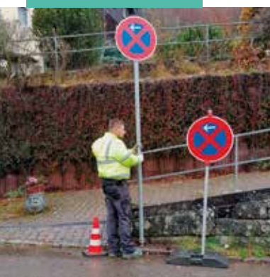
Die Mitarbeiter stellen auch Verkehrsschilder auf, etwa wenn aufgrund einer Baustelle Park- und Halteverbote nötig sind
