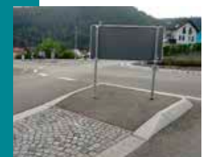
Kreisverkehr Höfener Straße / Kriegsstraße
