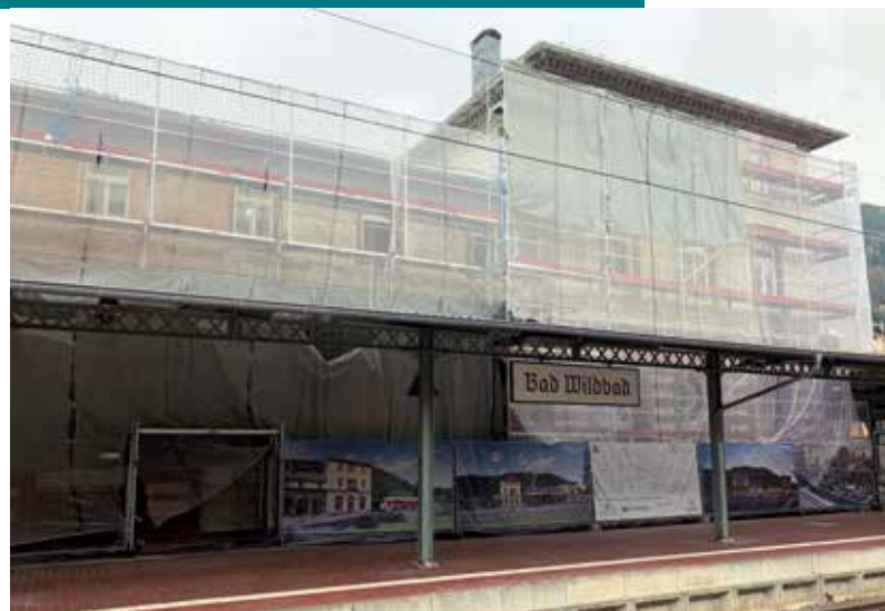
Der Bahnhof in Wildbad wird wohl noch einige Wochen eingerüstet bleiben.
