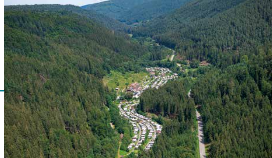
rechts: Luftaufnahme Kleinenzshof
