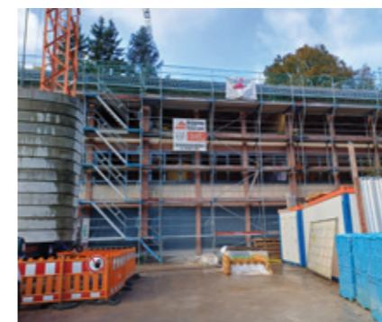
Bauteil B des Schulgebäudes wird inklusive Dach und Fenstern völlig kernsaniert.
