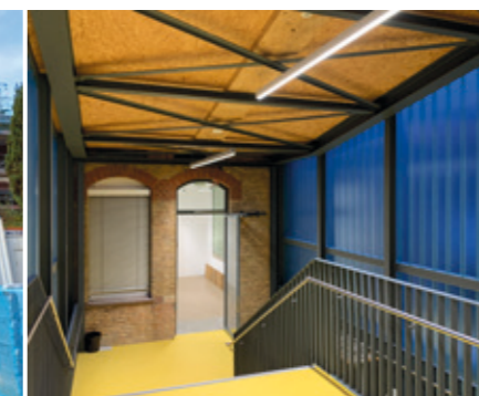
Über den Zwischenbau mit Aufzug sind alle Gebäudeteile miteinander verbunden und die Stockwerke barrierefrei zugänglich.
