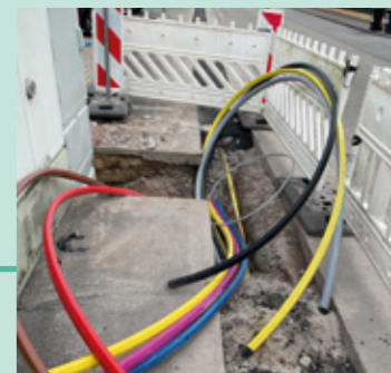
Verlegung der Breitbandverbände im Enzring
