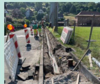
Verlegung der Breitbandverbände im Enzring
