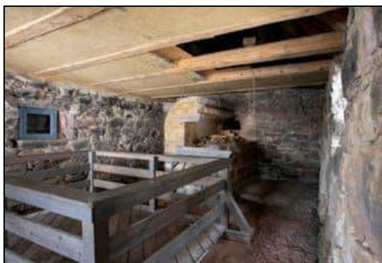
Abbildung 36: Rußhütte Enzklösterle, erbaut 1829 ( https://enzkloesterle.de )
