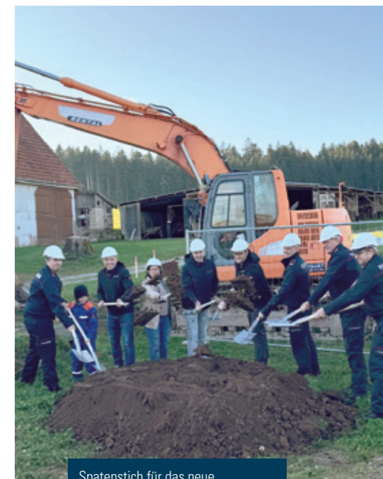
Spatenstich für das neue Gerätehaus der Freiwilligen Feuerwehr in den Bergorten
