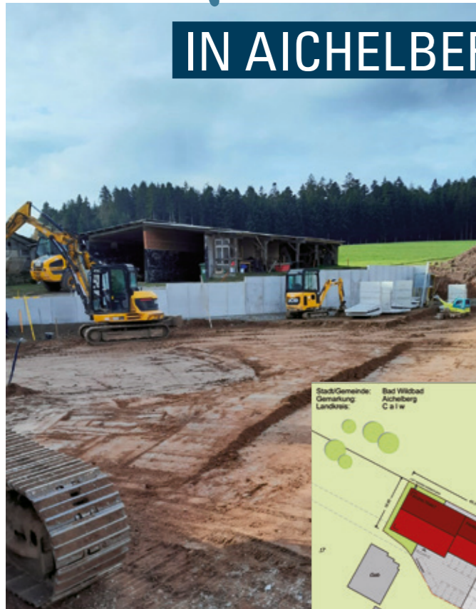
Rohbauarbeiten am neuen Standort
