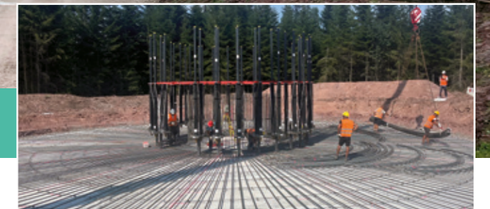
Bauarbeiten am Fundament der Windräder und bei der Aufstellung der einzelnen Stahlturmelemente
