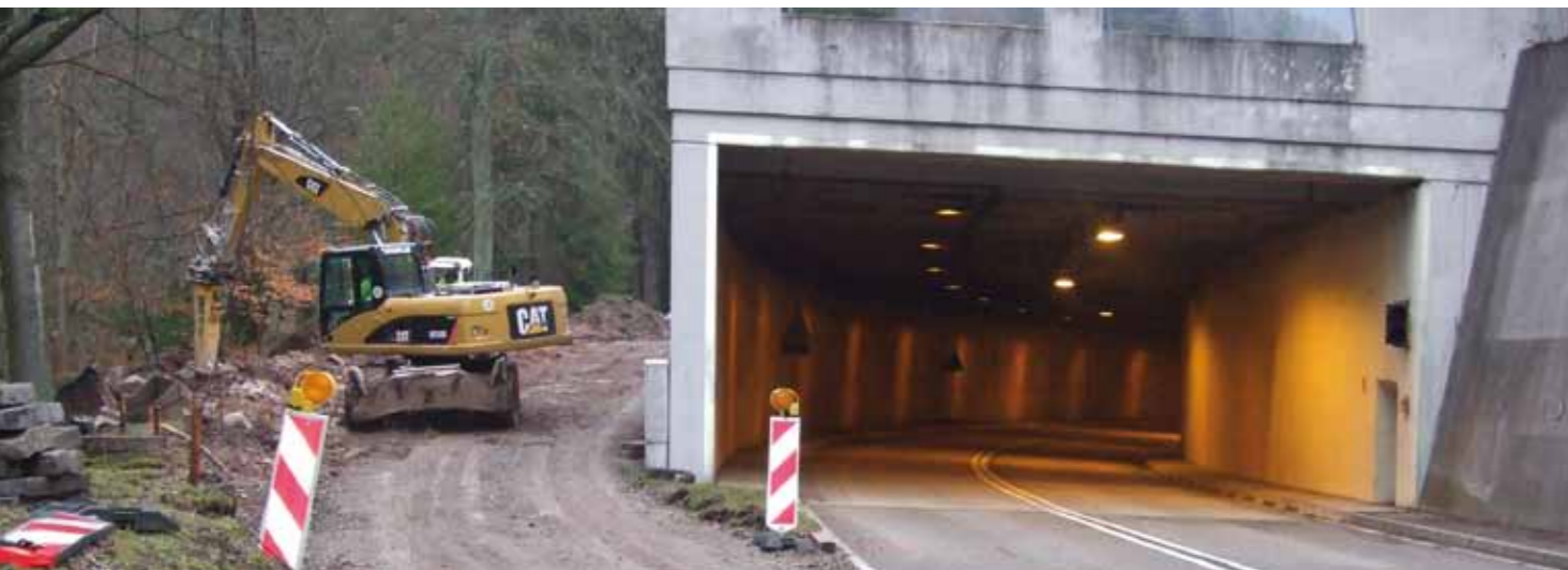
Die Sanierung des Meisterntunnels erfordert eine Umleitung des Verkehrs. An der Umfahrstrecke beim Südportal wird bereits gebaut
