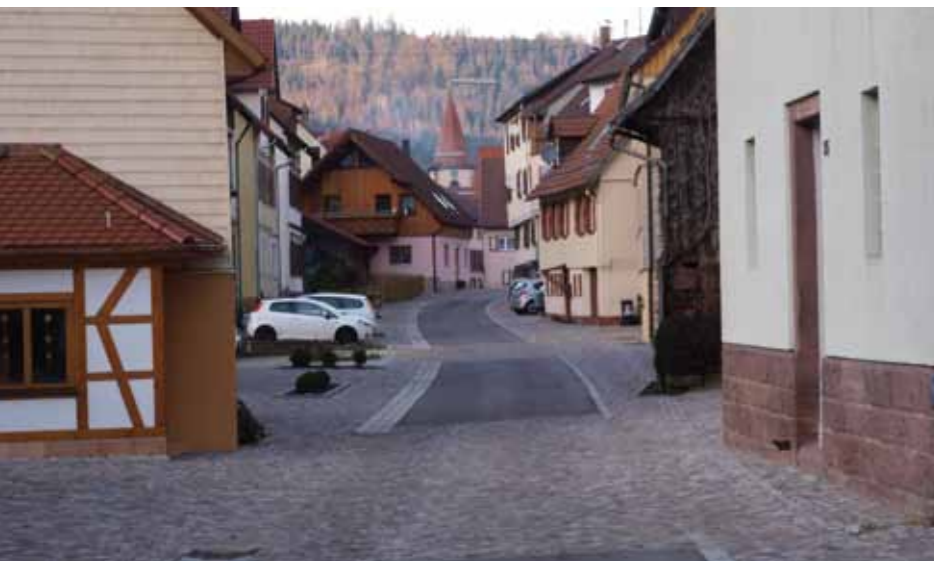
Nur noch das Grün, der historische Brunnen und die neue Straßenbeleuchtung fehlen in der Calwer Straße
